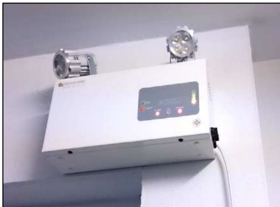
ภาพที่ 2-9 ระบบไฟฟ้าฉุกเฉิน
